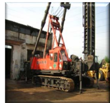
Cần cẩu P&H320 và dàn dẫn hướng đóng cọc bê tông
